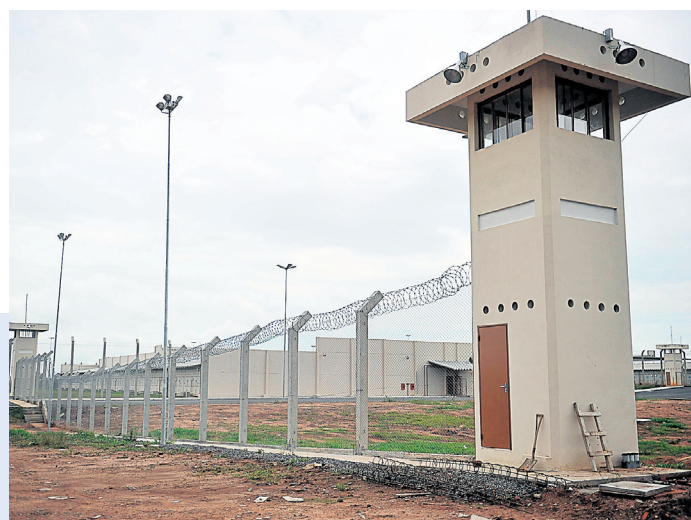
Cadeia em Santa Maria está com 98% das obras concluídas
